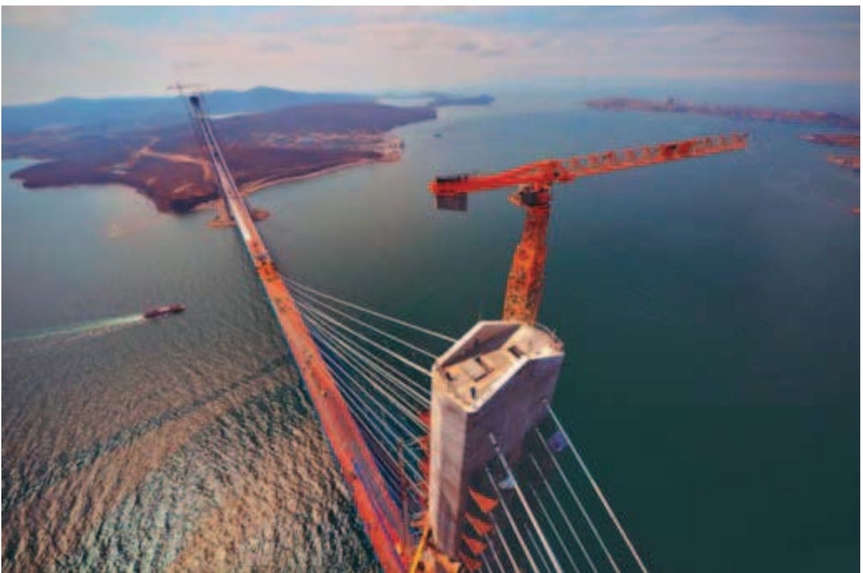
Рис. 115. Вантовый мост во Владивостоке, соединяющий полуостров Назимова с мысом Новосильского на острове Русском. Имеет самый большой в мире пролёт среди вантовых мостов, длиной 1104 метра, и пилоны высотой 324 м.
