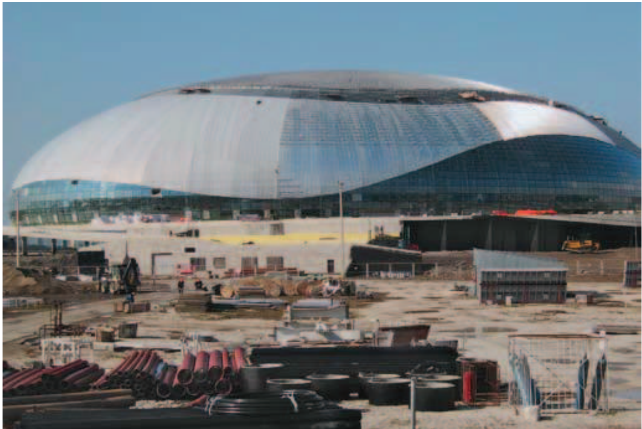
Рис. 114. Ледовый дворец «Большой», строящийся для Олимпиады-2014 в г. Сочи
